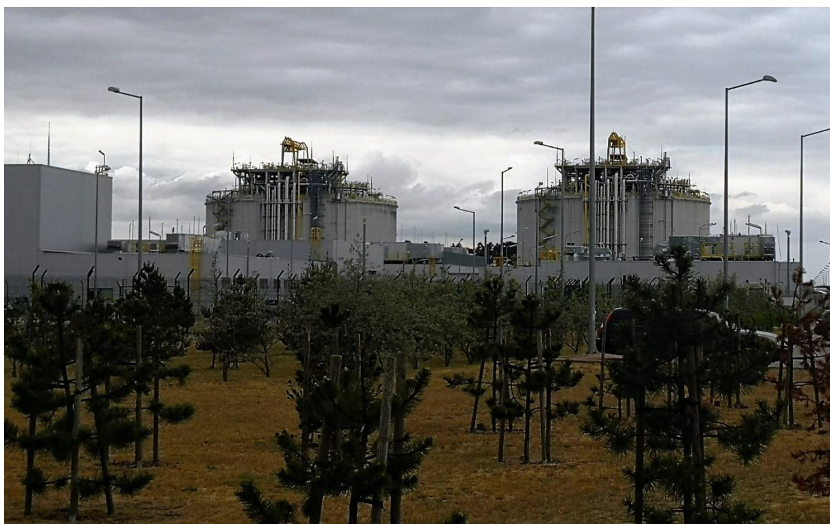
Fot. 1 Zbiorniki kriogeniczne o pojemności 160 tys.m 3 ciekłego gazu w Terminalu LNG w Świnoujściu. Źródło: materiały prywatne autora.
